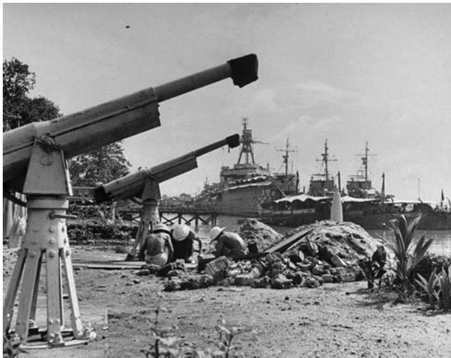
Công nhân đang tu bổ một công viên trên Quay Le Myre de Villiers (Bến Bạch Đằng) cạnh sông Sài Gòn.
