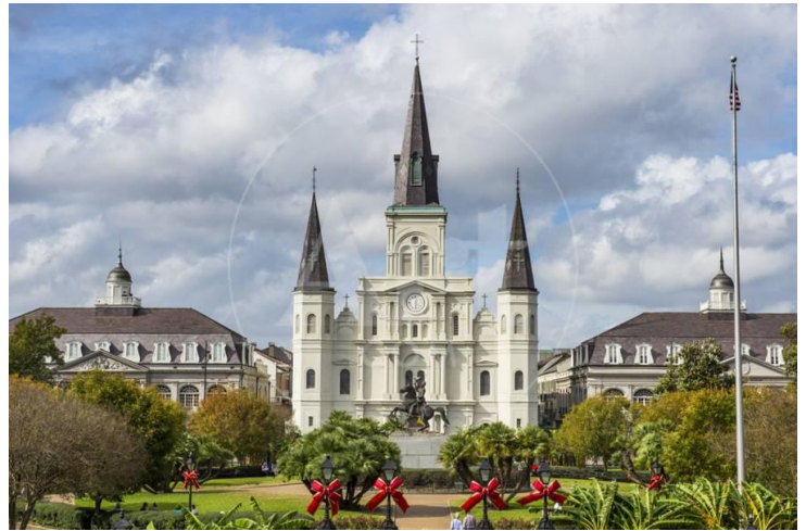
Nhà thờ St Louis tại khu công trường Jackson
