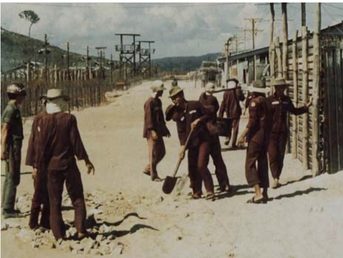
Sửa chữa đường sá khu vực vòng quanh trại giam
