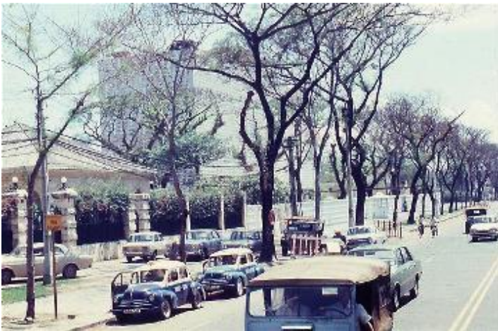
Tòa Đại sứ Hoa Kỳ 6 tầng oai nghi mới xây xong trên đại lộ Thống Nhất quận I Sài Gòn năm 1967.
